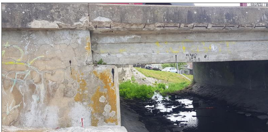
uložení na opěru 1 na vtoku a těsnící profil na hraně přepadu zasazený do opěry
