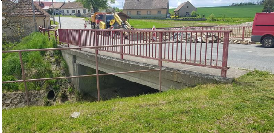
stav zábradlí a jeho nátěr
