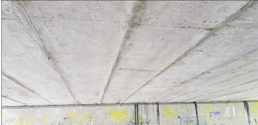
nosníky docela suché, jen malé krytí třmínků
