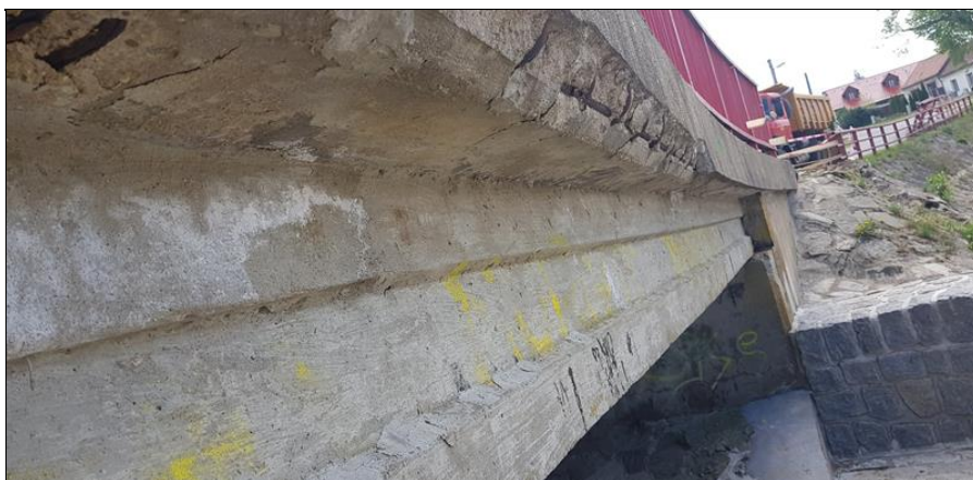
odpadlé krytí římy na vtoku (pravá strana)
